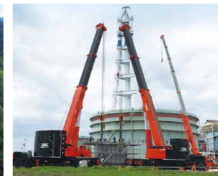
武豊火力発電所 トランス解体 550tx2
