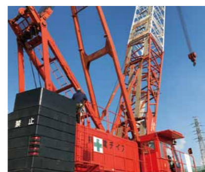
名南エネルギープラント工事
