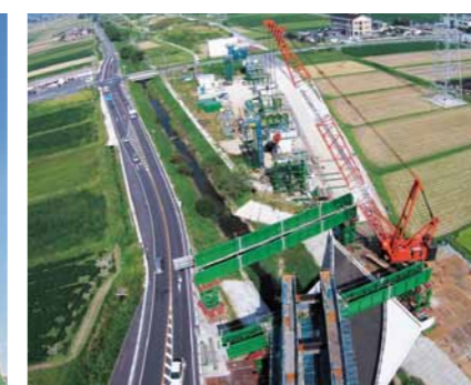
吉沢高架橋 300tcc
