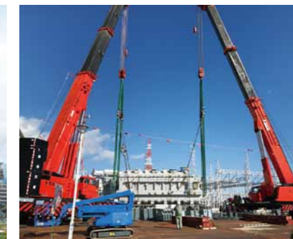
西尾張変電所・トランス解体
