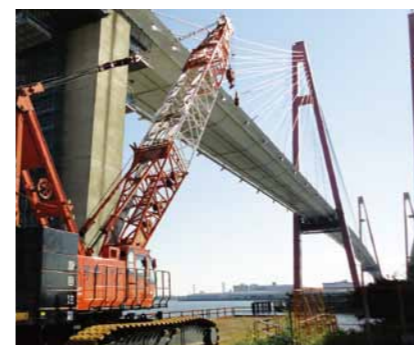
名港西大橋 補修工事 120tcc
