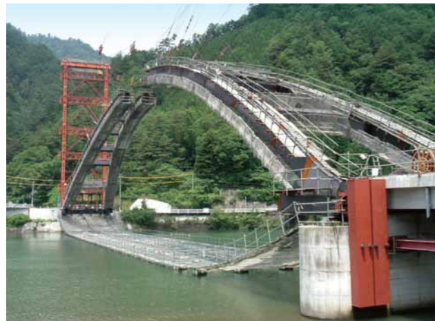
ケーブル斜吊り
