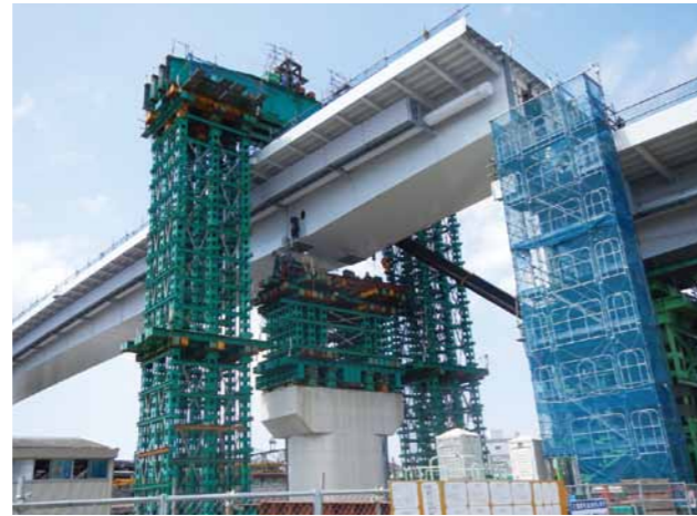
ジャッキ降下
